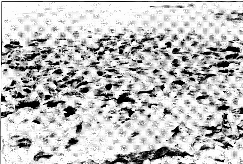
Photo 4. Structure de surface du beach-rock (actions mécanique et biochimique, recouvrement des cavités).
